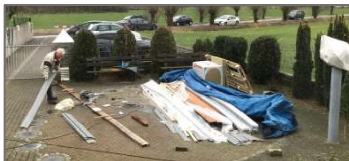
De nieuwe buitenwand van het auditorium nadert voltooiing. Hier zaagt Anton Valks kunststoffen platen op maat. Lees meer op blz. 13.
